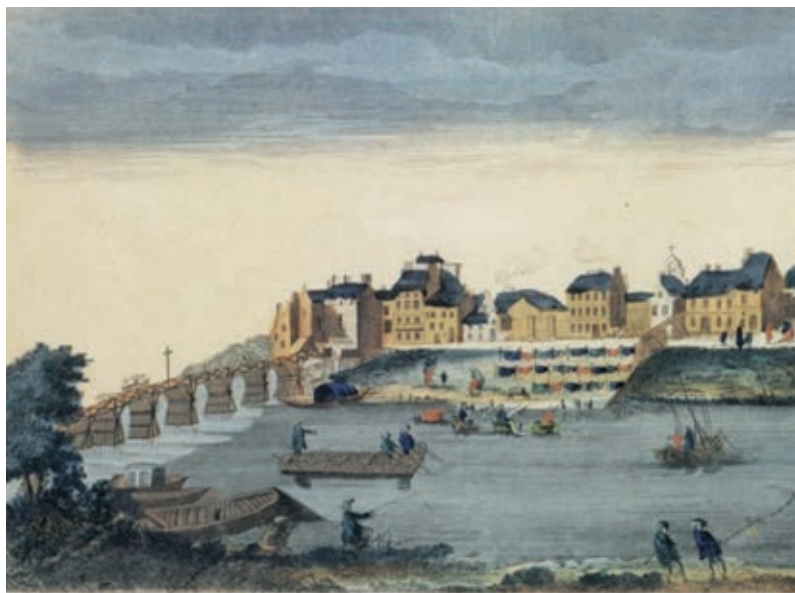
Figure 21. Neuilly et son pont de bois.
